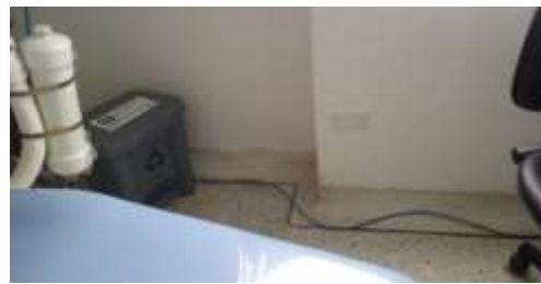
CAMI USS Nazareth Se evidencia cable de red pegado en la pared con cinta en un consultorio, cables desordenados.
