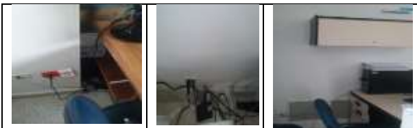
CAMI USS Nazareth Se evidencia cable de red pegado en la pared con cinta en un consultorio, cables desordenados.
