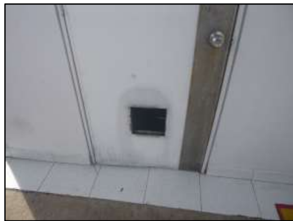
Ilustración 92. La puerta del almacenamiento no permite limpieza y desinfección, U.S.S. Candelaria II.
