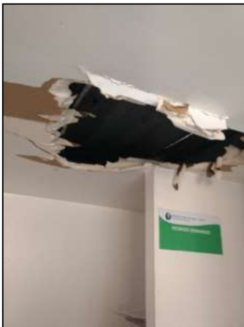
Ilustración 103. Techo de la unidad durante la visita inicial
