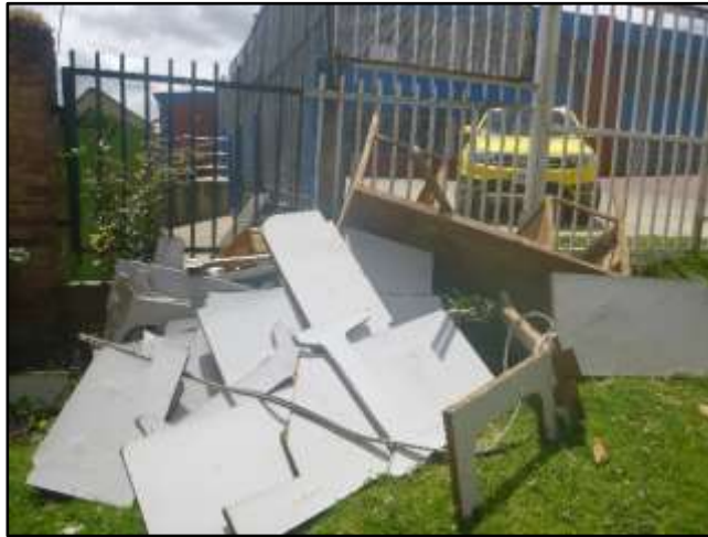
Ilustración 105. Residuos de madera sin almacenamiento adecuado U.S.S. Sierra Morena
