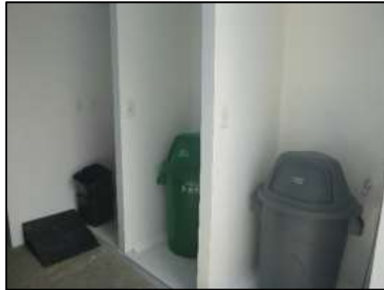
Ilustración 78. almacenamiento no cuenta con señalización. U.S.S. Limonar
