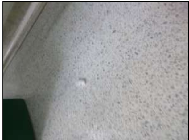
Ilustración 117. Algodón en el piso C.A.P.S. Vista Hermosa
