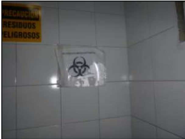
Ilustración 64. Señalización que no permite limpieza y desinfección, U.S.S. Meissen.
