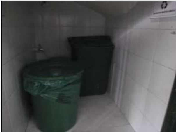
Ilustración 93. Paredes sin media caña, U.S.S. Candelaria II.
